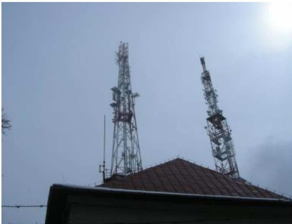
Fot. 1. RTON Wałbrzych Chelmiec – widok obiektu
