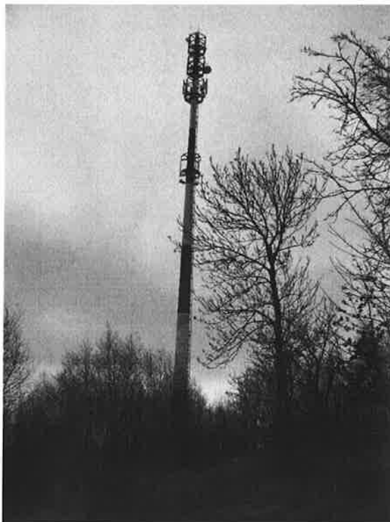
Zal. nr 1: Widok ogólny instalacji radiokomunikacyjnej.
