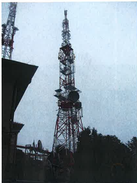
Zal. nr 1: Widok ogólny instalacji radiokomunikacyjnej.
