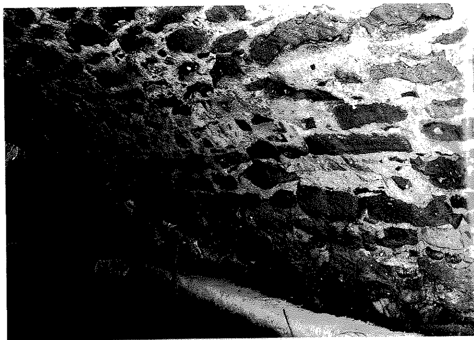
Rys. nr 24. Widok szczegółowy od strony dolnej wody sklepienia nad lewym przyczółkiem.
