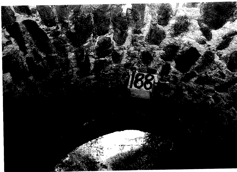
Rys. nr 23. Widok szczegółowy od strony dolnej wody konstrukcji sklepienia w jego kluczu. Widoczna korozja spoin pomiędzy elementami kamiennymi.
