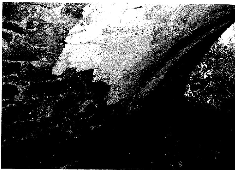
Rys. nr 22. Widok szczegółowy od strony dolnej wody skrajnej części sklepienia nad prawym przyczółkiem. Widoczny zakres naprawy sklepienia za pomocą betonu.
