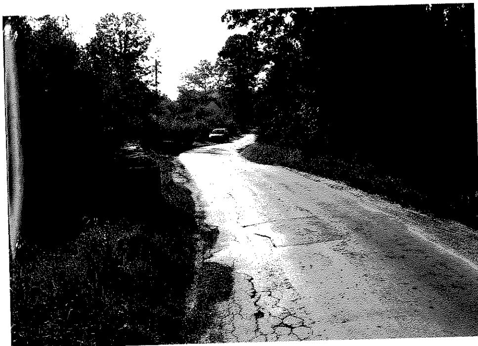
Rys. nr 2. Widok ogólny dojazdu do mostu od strony Rzeczki. Widoczny brak opasek bezpieczeństwa lub chodników na moście. Widoczne również wielokierunkowe spękania w nawierzchni.
