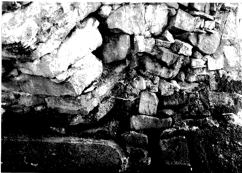
Rys. nr 33. Widok szczegółowy od strony dolnej wody oparcia sklepienia na lewym przyczółku. Widoczny brak spoin pomiędzy elementami kamiennymi.
