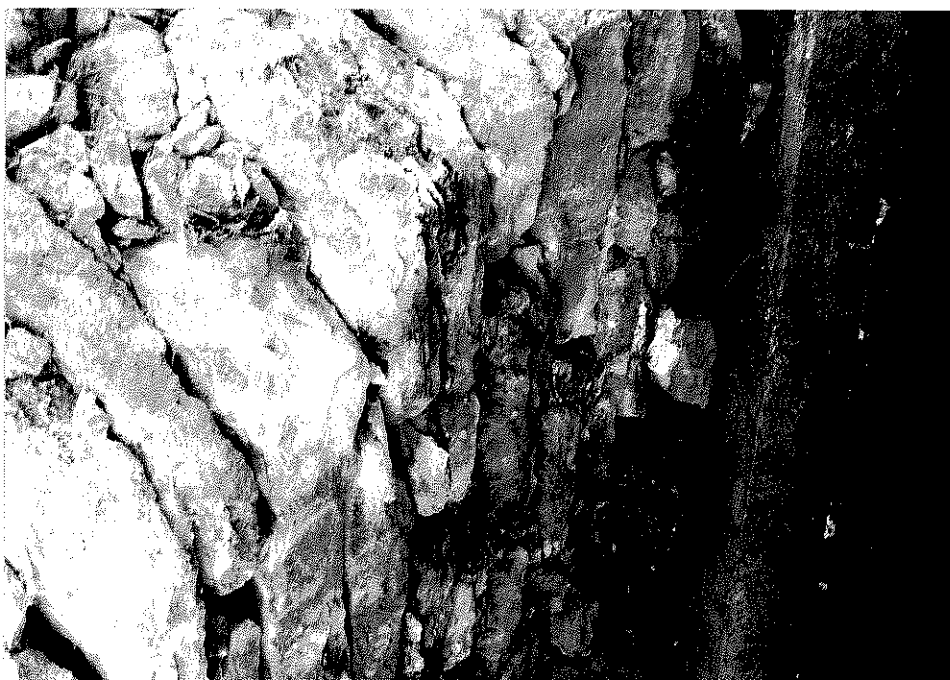
Rys. nr 34. Widok szczegółowy od strony dolnej wody oparcia sklepienia na lewym przyczółku. Widoczny brak spoin pomiędzy elementami kamiennymi.
