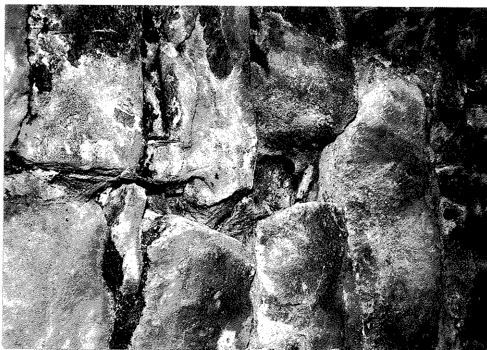
Rys. nr 27. Widok szczegółowy ubytków spoin pomiędzy elementami kamiennymi w sklepieniu.
