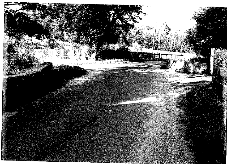
Rys. nr 5. Widok ogólny nawierzchni na moście. Widoczne uszkodzenia nawierzchni wzdłuż styku roboczego.
