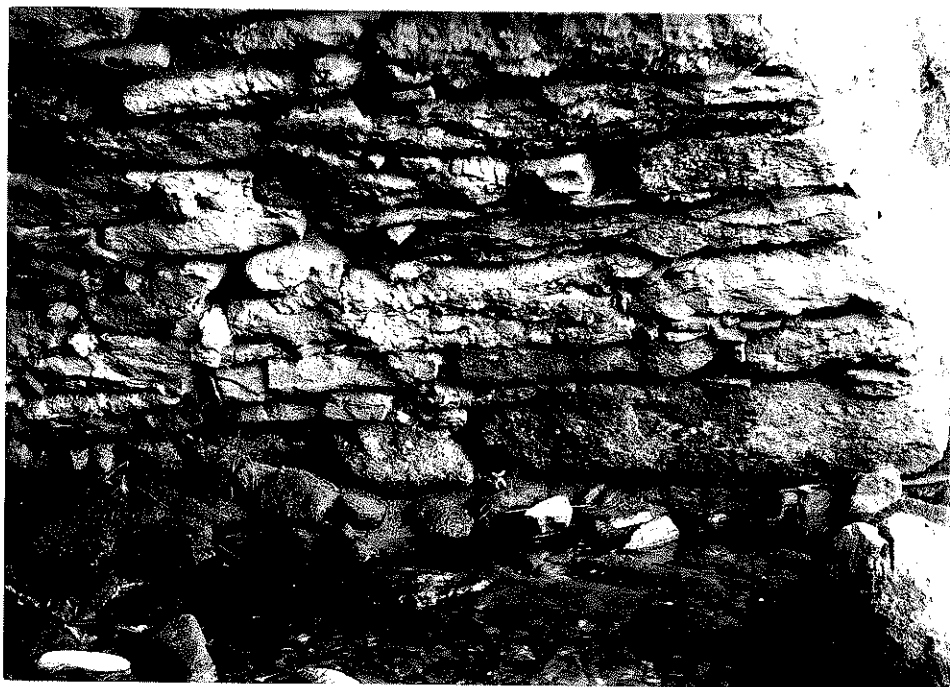
Rys. nr 21. Widok szczegółowy od strony dolnej skrajnej części sklepienia nad lewym przyczółkiem. Widoczne duże ubytki spoin pomiędzy elementami kamiennymi.
