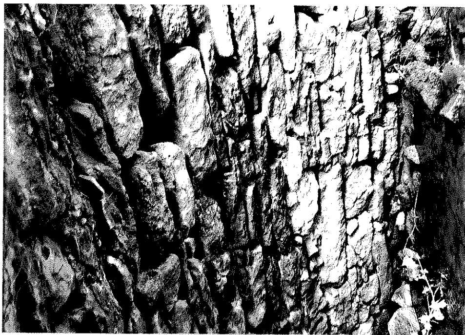
Rys. nr 22. Widok szczegółowy środkowej części sklepienia nad lewym przyczółkiem. Widoczne bardzo duże ubytki spoin pomiędzy elementami kamiennymi.
