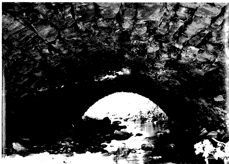
Rys. nr 20. Widok ogólny od strony dolnej wody z podu kamiennego sklepienia. Widoczne duże ubytki spoin pomiędzy elementami kamiennymi.
