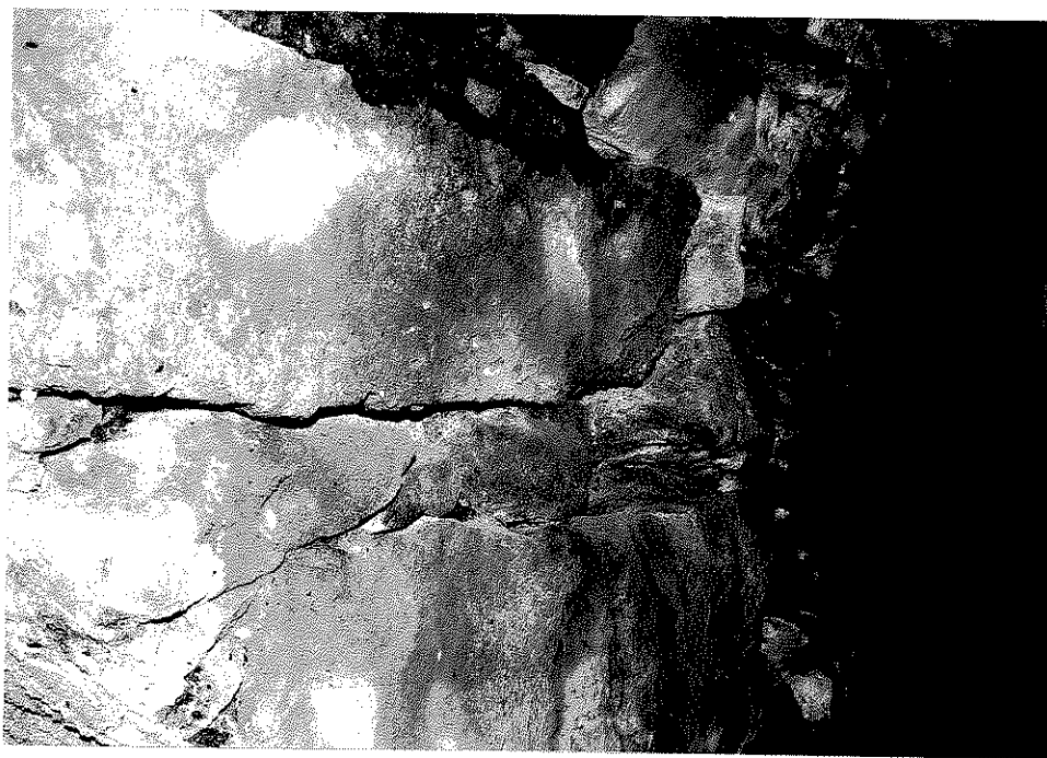
Rys. nr 26. Widok szczegółowy ubytków spoin pomiędzy elementami kamiennymi w sklepieniu.
