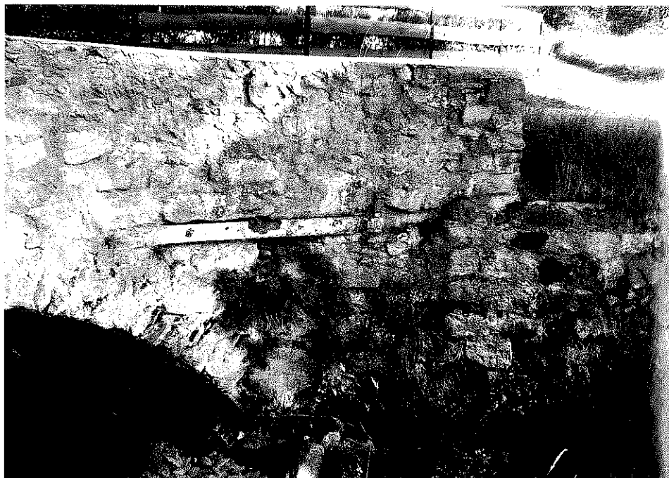
Rys. nr 19. Widok szczegółowy od strony dolnej wody kamiennego sklepienia, kamiennej ściany czołowej i kamiennego muru oporowego nad lewym przyczółkiem. Widoczna roślinność porastająca pomiędzy elementami kamiennymi oraz. Widoczne również wzmocnienie ściany czołowej za pomocą stalowego elementu.
