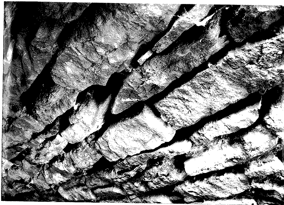
Rys. nr 25. Widok szczegółowy ubytków spoin pomiędzy elementami kamiennymi w sklepieniu. Widoczne bardzo duże ubytki spoin.
