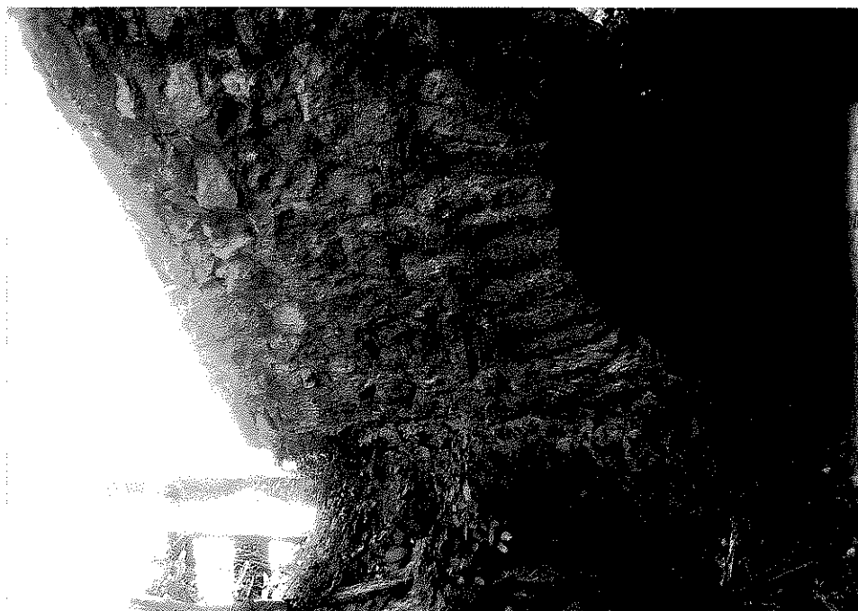
Rys. nr 8. Widok ogólny od strony górnej wody kamiennego sklepienia i kamiennej ściany czołowej nad lewym przyczółkiem.
