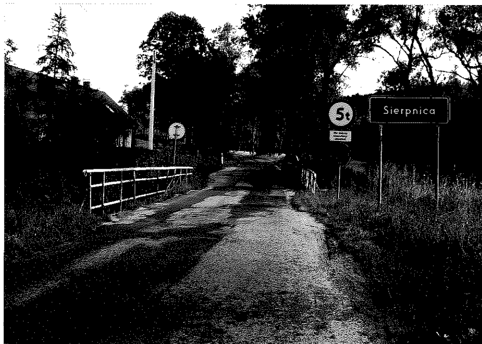
Rys. nr 2. Widok ogólny dojazdu do mostu od strony Kolc.
