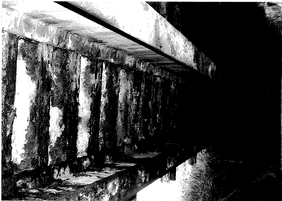
Rys. nr 21. Widok od spodu konstrukcji przęsła – część skrajna od strony górnej wody. Widoczna zaawansowana korozja skrajnego dźwigara i stopek kształtowników Zoresa.
