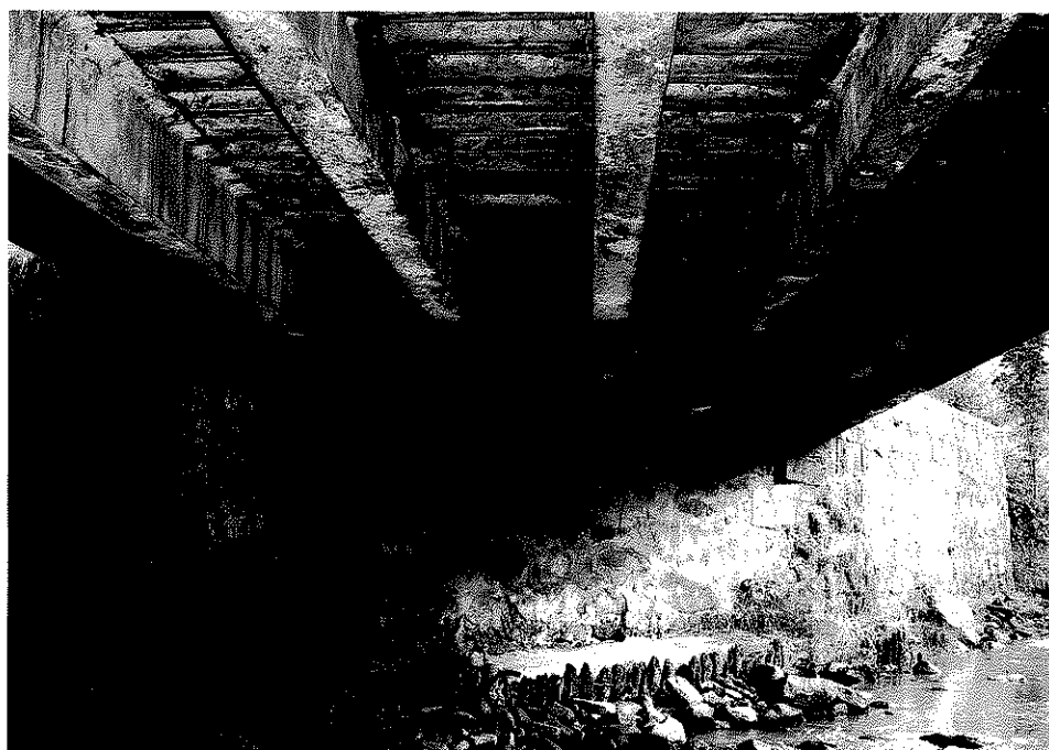
Rys. nr 14. Widok ogólny prawego przyczółka.
