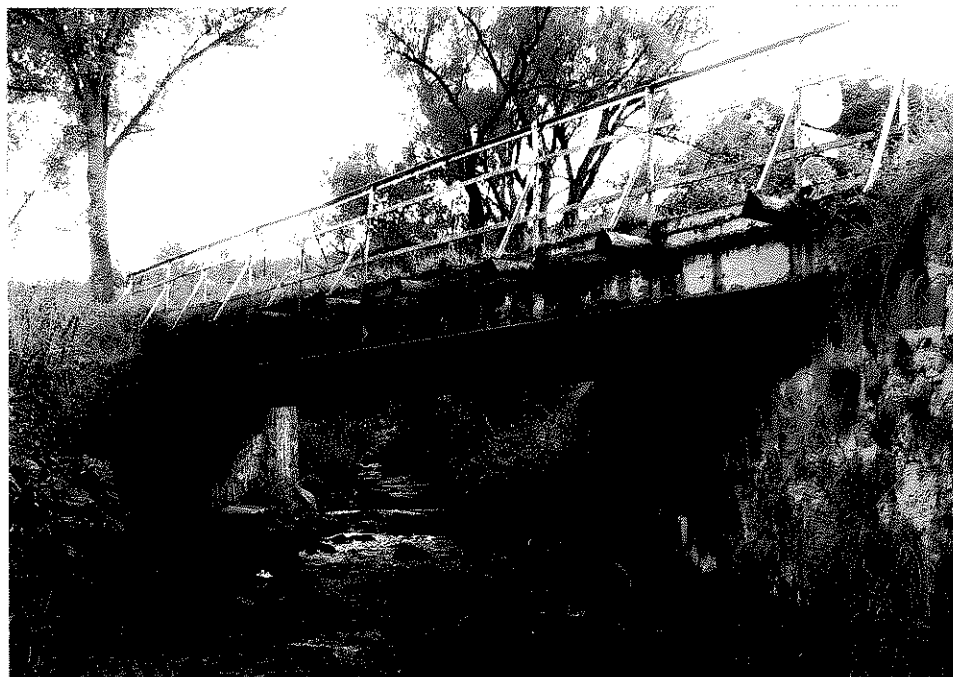
Rys. nr 16. Widok ogólny mostu od strony dolnej wody.
