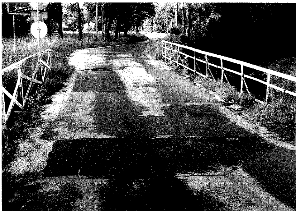
Rys. nr 7. Widok ogólny od strony Sierpnicy nawierzchni na moście . Widoczne sfałdowania, wielokierunkowe spękania oraz niskiej jakości naprawy nawierzchni.
