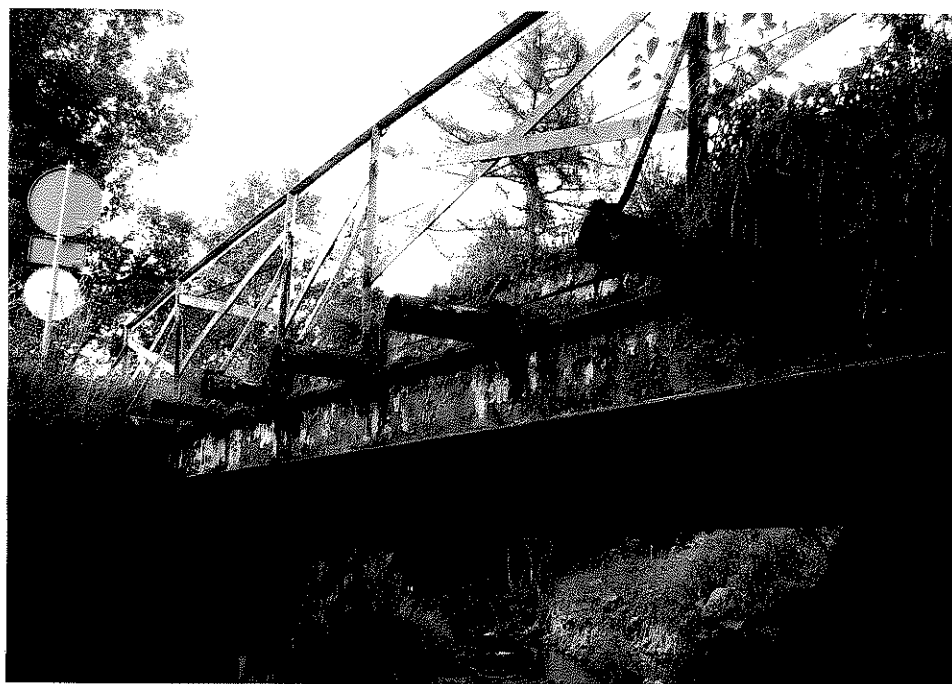
Rys. nr 10. Widok z boku przęsła od strony górnej wody. Widoczna zniszczona powłoka antykorozyjna oraz roślinność porastająca elementy mostu.
