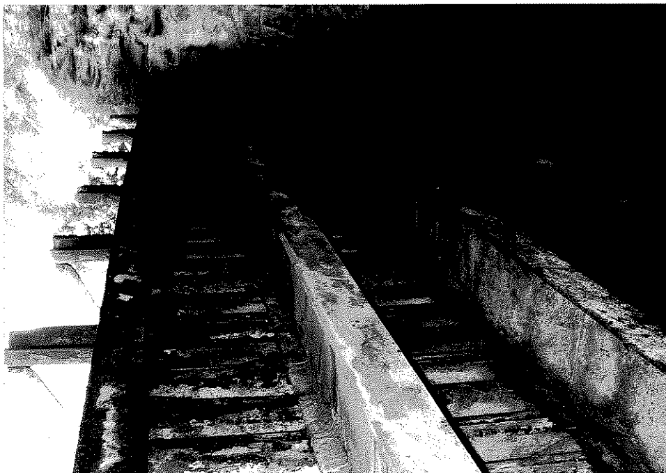
Rys. nr 23. Widok od spodu konstrukcji przęśla – część skrajna od strony dolnej wody. Widoczna zaawansowana korozja skrajnego dzwigara i stopki kształowników Zoresa.
