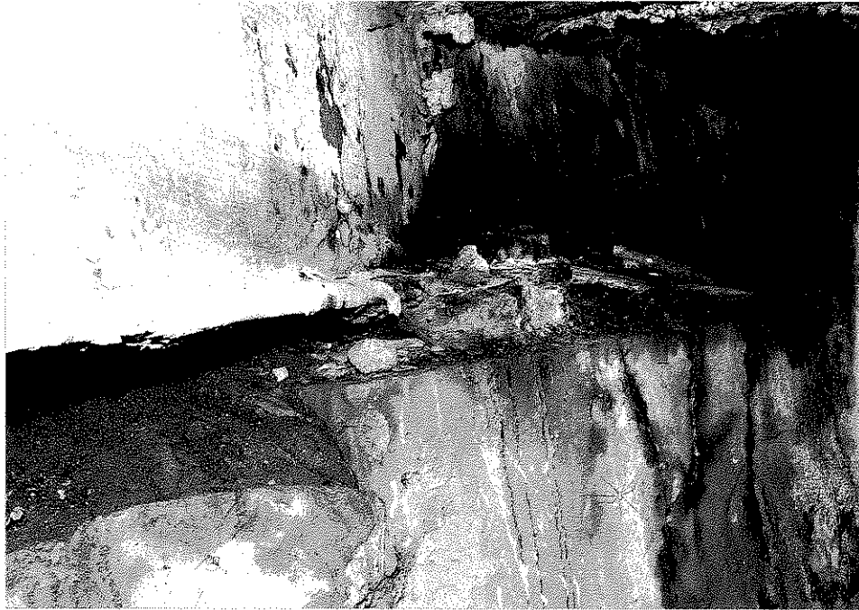
Rys. nr 19. Widok szczegółowy oparcia dźwigara na ławie podłożyskowej z elementów kamiennych. Widoczne zanieczyszczenia i korozja elementów stalowych w miejscu oparcia dźwigara.
