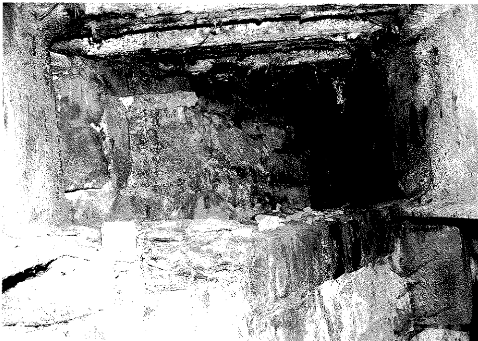
Rys. nr 20. Widok szczegółowy ścianki żwirowej wykonanej z elementów kamiennych.
