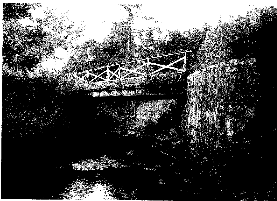
Rys. nr 9. Widok ogólny mostu od strony górnej wody.
