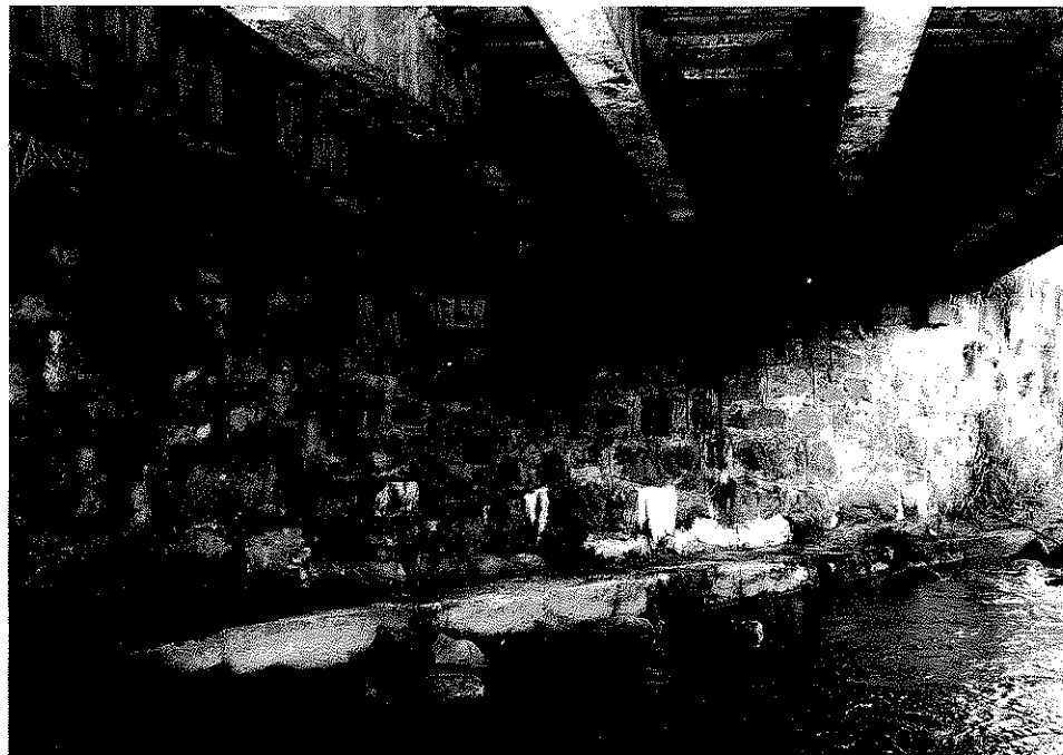
Rys. nr 13. Widok ogólny lewego przyczółka.
