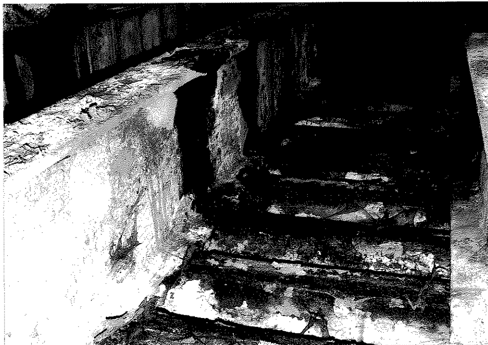
Rys. nr 23. Widok od spodu konstrukcji przęśla – część skrajna od strony dolnej wody. Widoczna zaawansowana korozja skrajnego dzwigara i stopki kształowników Zoresa.
