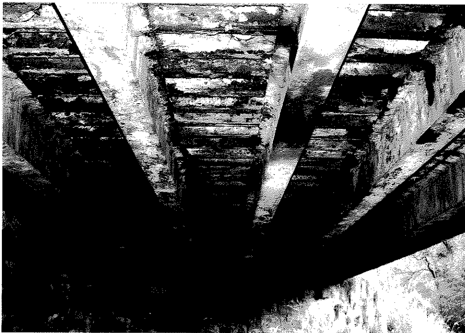
Rys. nr 22. Widok od spodu konstrukcji przęsła – część środkowa. Widoczna zaawansowana korozja stopek kształtowników Zoresa
