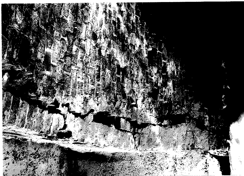
Rys. nr 31. Widok szczegółowy od strony dolnej wody odspojenia skrajnej części sklepienia (widok w kierunku prawego przyczółka).
