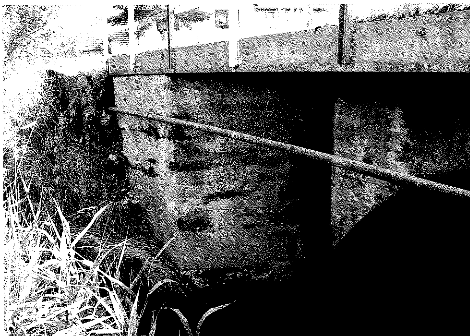
Rys. nr 10. Widok ogólny od strony górnej wody lewego przyczółka. Widoczne zawilgocenia na ścianie przyczółka.
