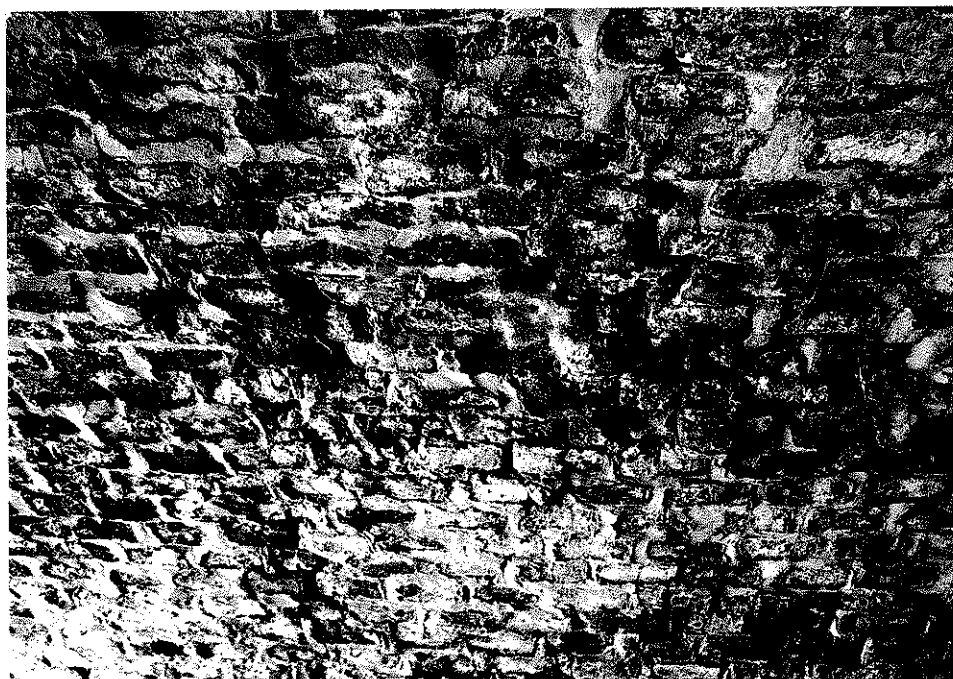
Rys. nr 40. Widok szczegółowy powierzchni ceglanego sklepienia. Widoczne pęknięcia, ubytki spoin i wylugowania zaczynu cementowego.
