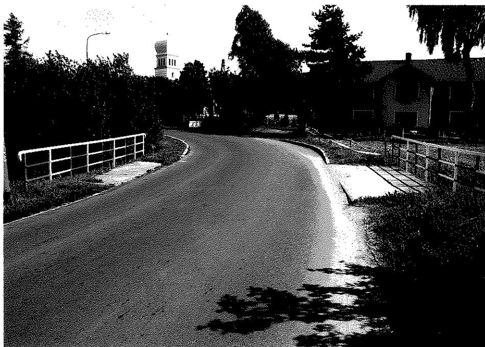
Rys. nr 1. Widok ogólny dojazdu do mostu od strony Czarnego Boru.
