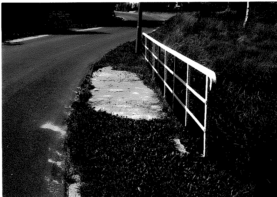
Rys. nr 3. Widok ogólny chodnika i balustrady usytuowanych od strony górnej wody (widok w kierunku Czarnego Boru). Widoczna roślinność porastająca część chodnika.
