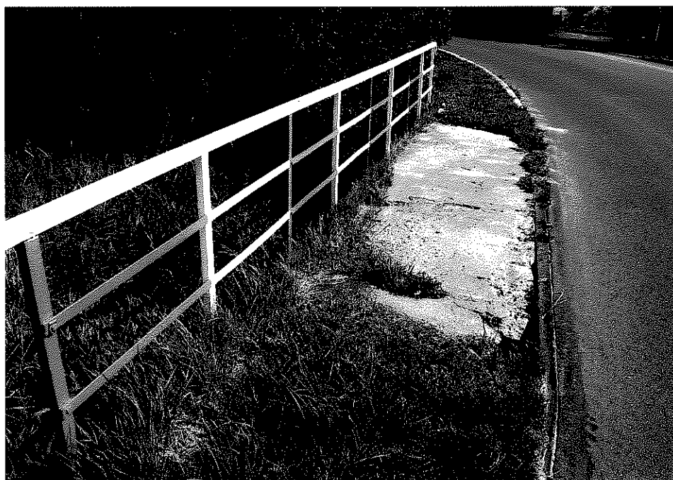
Rys. nr 4. Widok ogólny chodnika i balustrady usytuowanych od strony górnej wody (widok w kierunku Kuźnic Świdnickich). Widoczne uszkodzenie konstrukcji chodnika wzdłuż stalowego krawężnika. Widoczna również roślinność porastająca część chodnika.
