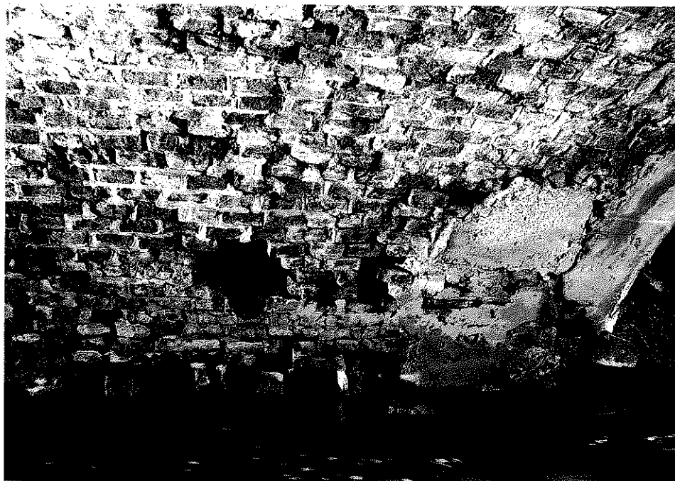
Rys. nr 21. Widok szczegółowy ceglanego sklepienia nad prawym przyczółkiem – część od strony górnej wody. Widoczne duże ubytki cegieł w sklepieniu, wykwyty zaczynu cementowego obejmujące całą powierzchnię sklepienia oraz ubytki spoin pomiędzy cegłami. Widoczne również miejsca naprawy sklepienia za pomocą betonu.
