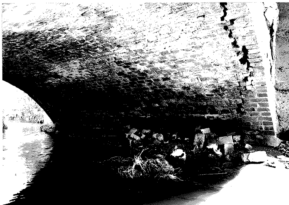
Rys. nr 34. Widok ogólny od strony dolnej wody sklepienia nad prawym przyczółkiem. Widoczny duży ubytek cegieł w strefie lustra wody.
