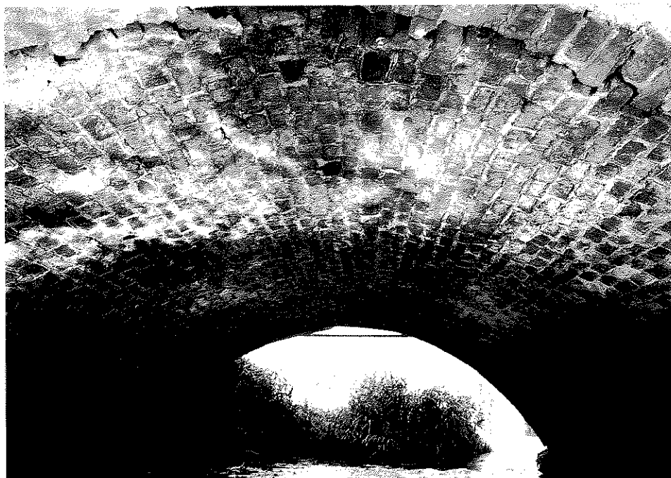
Rys. nr 39. Widok od strony dolnej wody konstrukcji ceglanego sklepienia. Widoczne wylugowania zaczynu cementowego obejmujące całą powierzchnię sklepienia.
