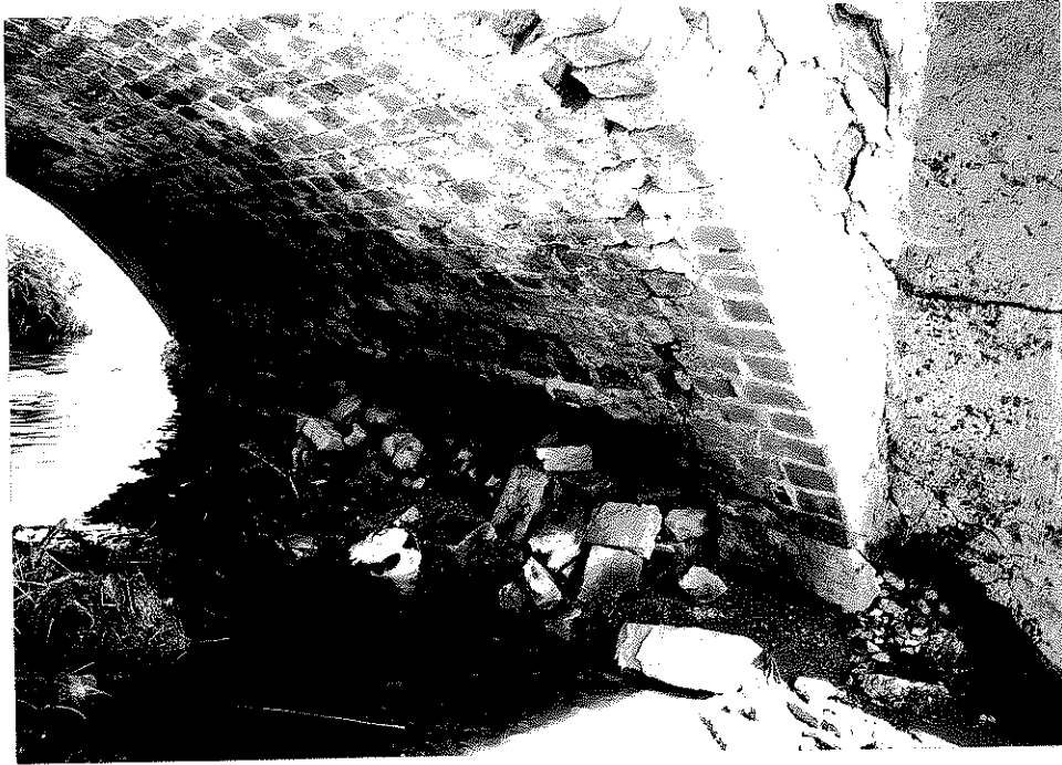
Rys. nr 35. Widok szczegółowy od strony dolnej wody ubytku cegieł w sklepieniu nad prawym przyczółkiem.
