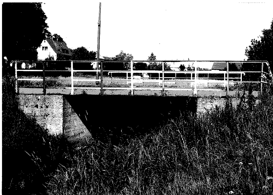
Rys. nr 26. Widok ogólny mostu od strony dolnej wody.
