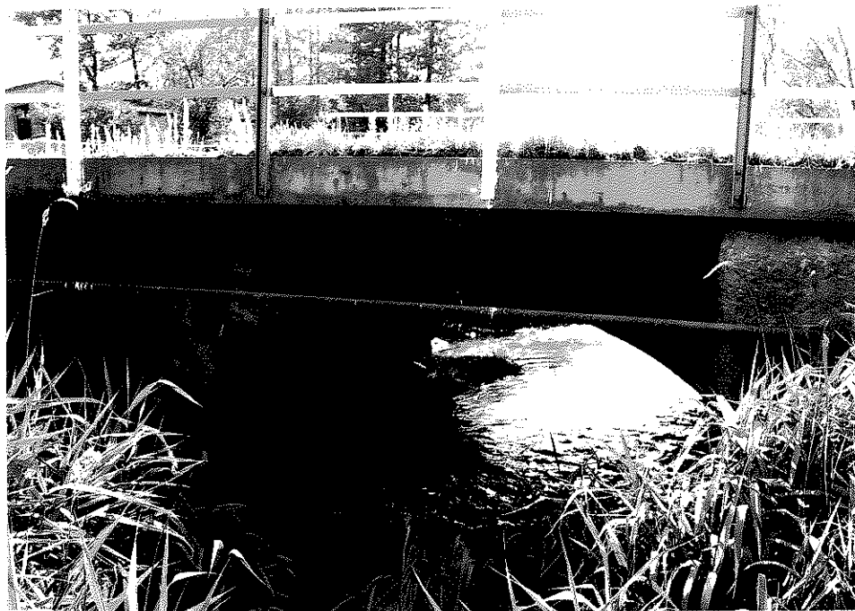
Rys. nr 9. Widok ogólny mostu od strony górnej wody.
