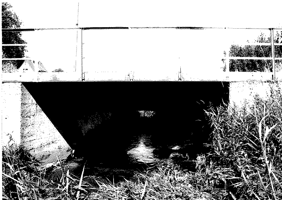
Rys. nr 27. Widok ogólny mostu od strony dolnej wody.
