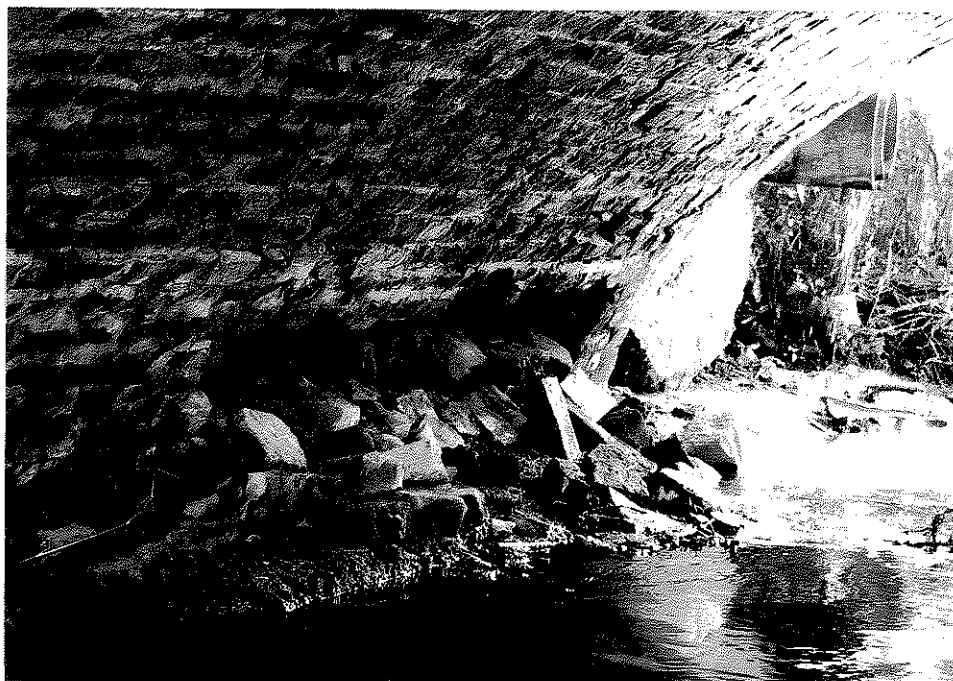
Rys. nr 19. Widok szczegółowy ubytku cegieł w sklepieniu nad lewym przyczółkiem – część od strony dolnej wody. Widoczny duży zakres ubytku.
