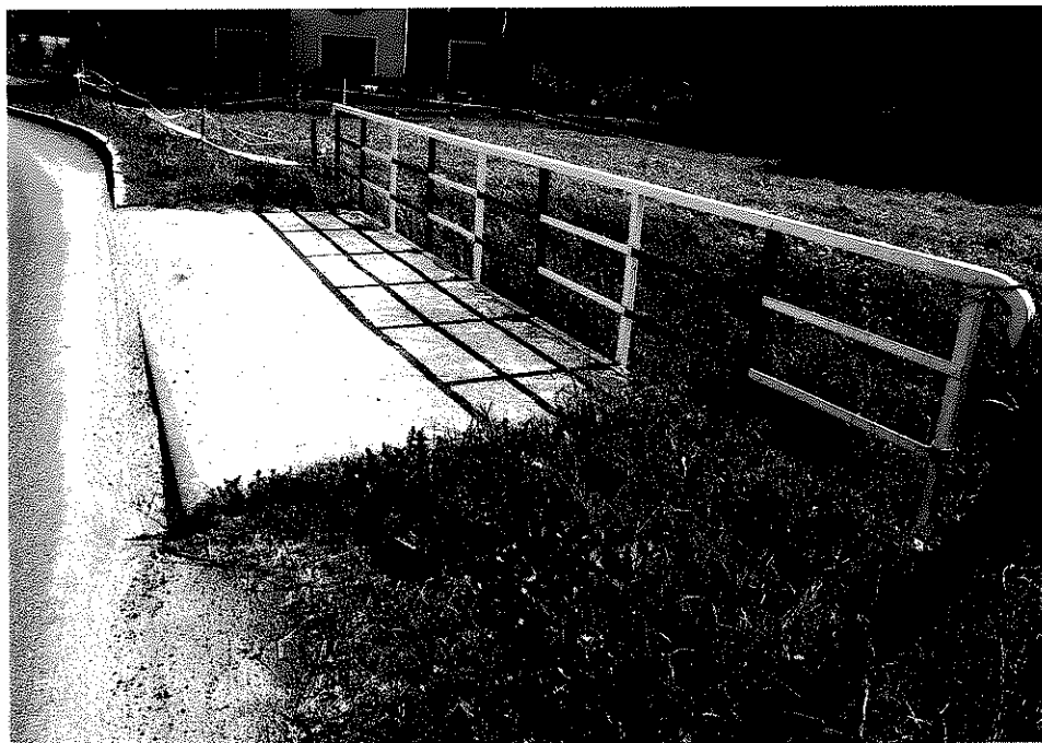
Rys. nr 7. Widok ogólny chodnika i balustrady usytuowanych od strony dolnej wody (widok w kierunku Kuźnic Świdnickich). Widoczne zanieczyszczenia wzdłuż krawężnika.
