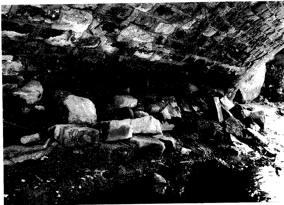
Rys. nr 36. Widok szczegółowy od strony dolnej wody głębokości ubytku cegieł w sklepieniu nad prawym przyczółkiem.
