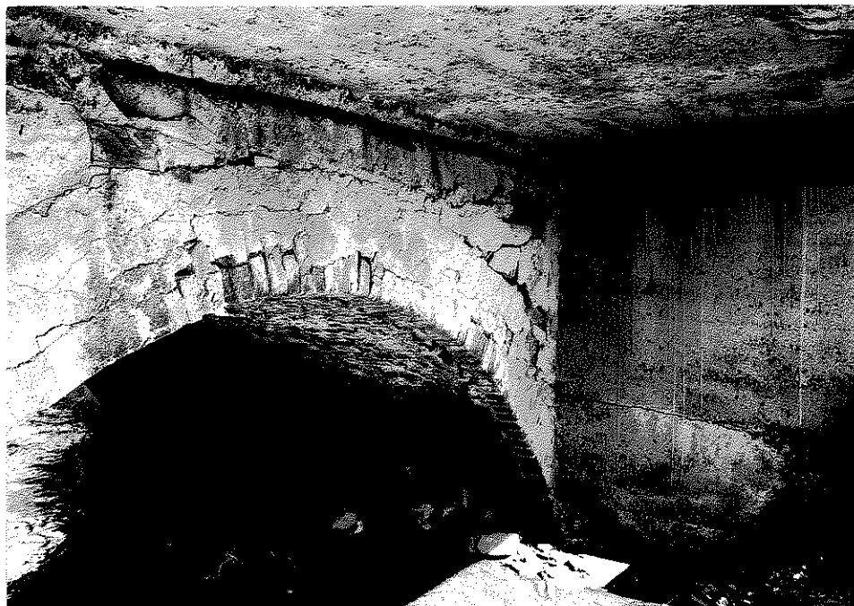
Rys. nr 33. Widok ogólny od strony dolnej wody przęsła nad lewym przyczółkiem. Widoczne wielokierunkowe spękania ściany czołowej.
