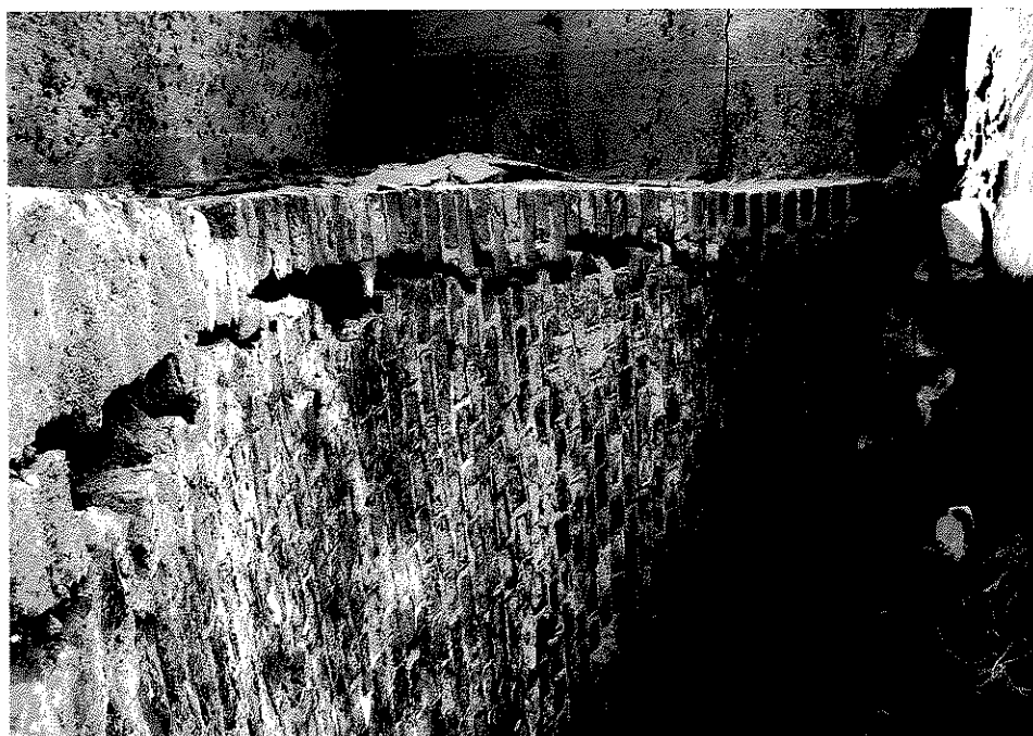
Rys. nr 32. Widok szczegółowy od strony dolnej wody odspojenia skrajnej części sklepienia (widok w kierunku lewego przyczółka).
