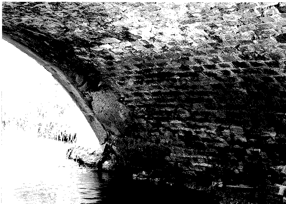
Rys. nr 17. Widok szczegółowy od strony dolnej wody ceglanego sklepienia nad lewym przyczółkiem. Widoczne ubytki cegieł w skrajnej części sklepienia. Widoczne również miejsca naprawy sklepienia za pomocą betonu.
