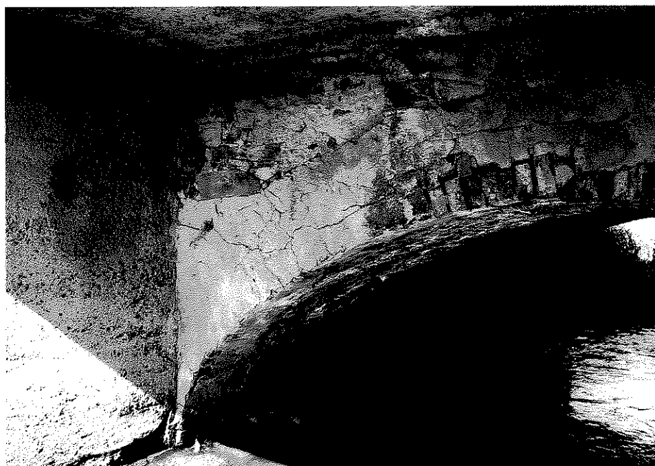
Rys. nr 28. Widok szczegółowy od strony dolnej wody ściany czołowej ceglanego sklepienia nad prawym przyczółkiem. Widoczne wielokierunkowe spękania ściany czołowej.
