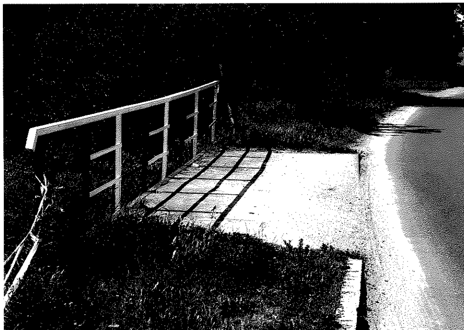
Rys. nr 6. Widok ogólny chodnika i balustrady usytuowanych od strony dolnej wody (widok w kierunku Czarnego Boru). Widoczne zanieczyszczenia wzdłuż krawężnika
