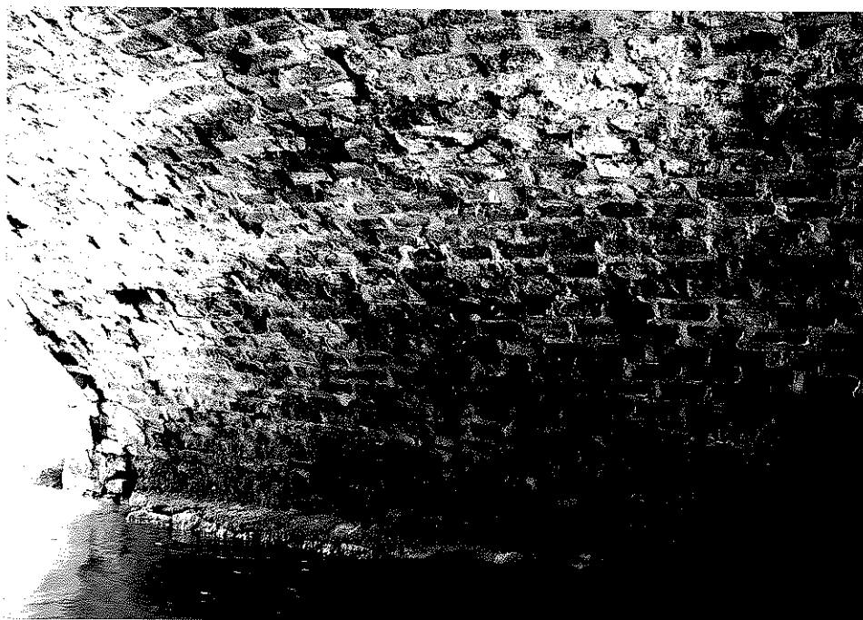
Rys. nr 22. Widok szczegółowy ceglanego sklepienia nad prawym przyczółkiem- część od strony dolnej wody. Widoczne wykwyty zaczynu cementowego obejmujące całą powierzchnię sklepienia oraz ubytki spoin pomiędzy cegłami.
